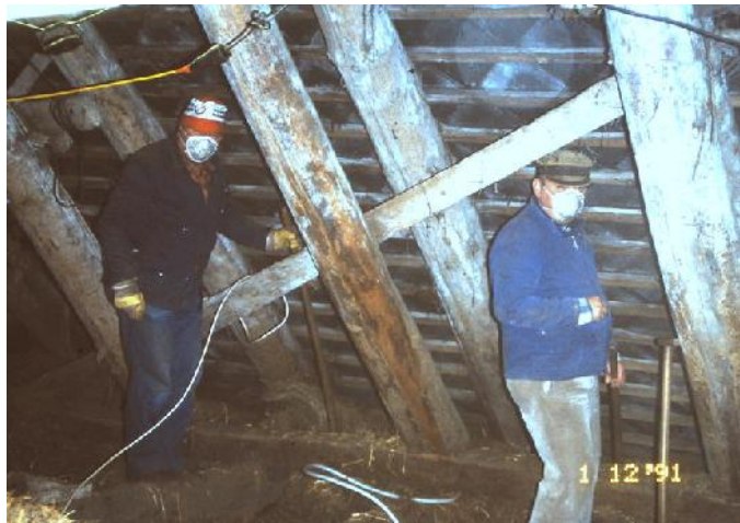
Die „Schietgang“ bei Aufräumarbeiten
