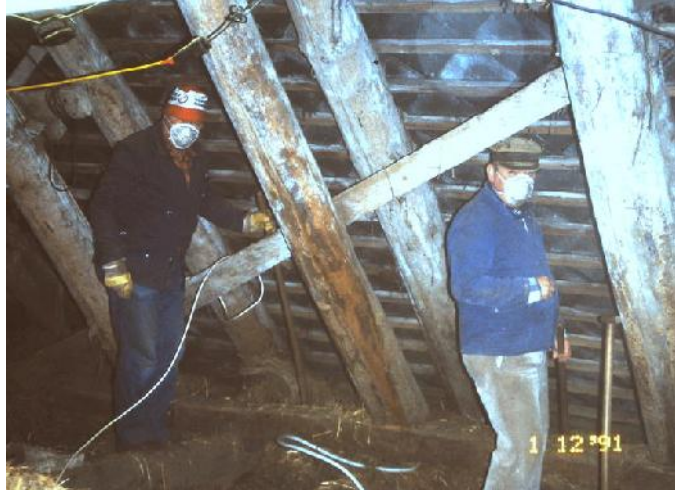
Die „Schietgang“ bei Aufräumarbeiten
